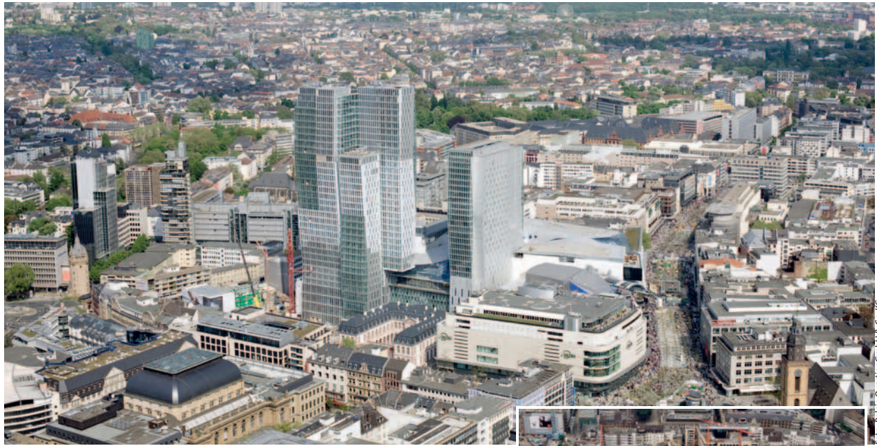
Palais Quartier zu Beginn der Bauarbeiten (kleines Foto) und kurz vor Abschluss: bis zu 300 Baustellentransporte täglich.
